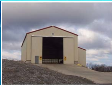
Door # 23 Unloading Area
